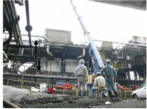
写真 5 投入状況 (地上より高さ約 30m・ブーム長 60m)
