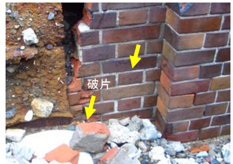
写真 13 目地材としてモルタル使用
