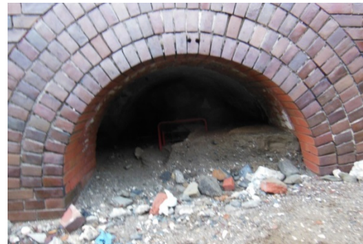
写真7 掩蔽壕の現況 (H26. 2)
