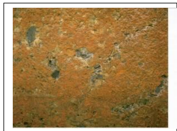
写真-4 貯留槽側部の溶脱（脆弱化）
