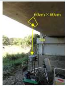
写真-4 音響探査による測定
