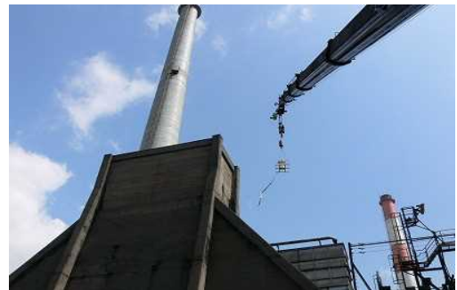
写真 6 ライブカメラによる内部投入監視
