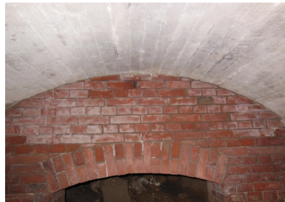
写真9 掩蔽壕内部の状況②
