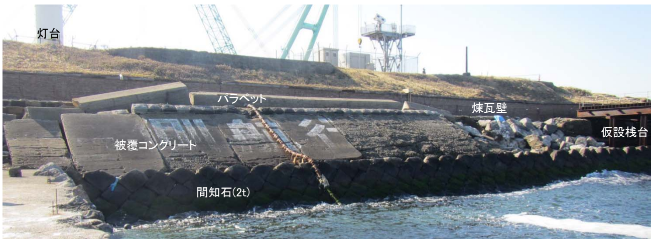
写真1 外周護岸及び煉瓦壁の現況
