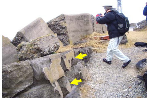
写真5 石積擁壁の現況
