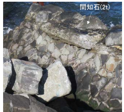
写真3 間詰めコンクリートの現況
