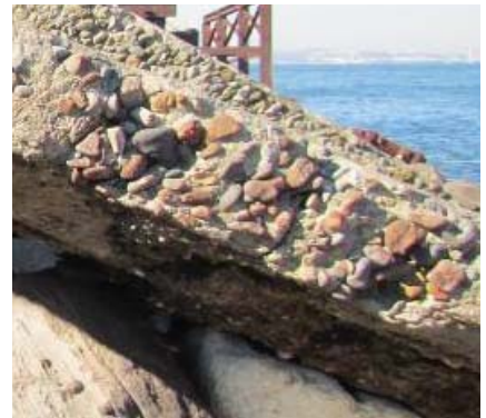
写真2 被覆コンクリートの現況
