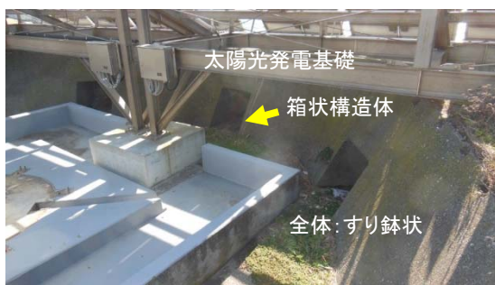
写真10 砲台①の箱状構造体
