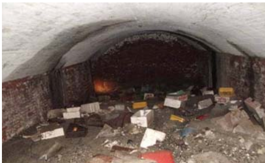
写真8 掩蔽壕内部の状況①
